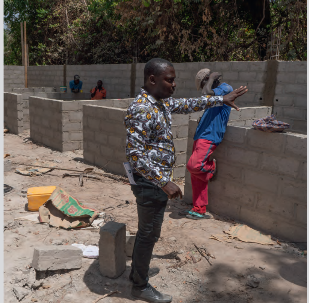
Maxime Gomis dirige les travaux lors de la construction de sa porcherie
